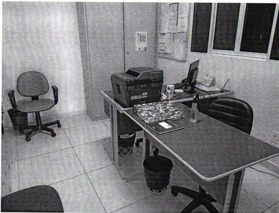
FOTO 11 – PEQUENOS ESPAÇOS E PAREDE COM INFILTRAÇÃO
